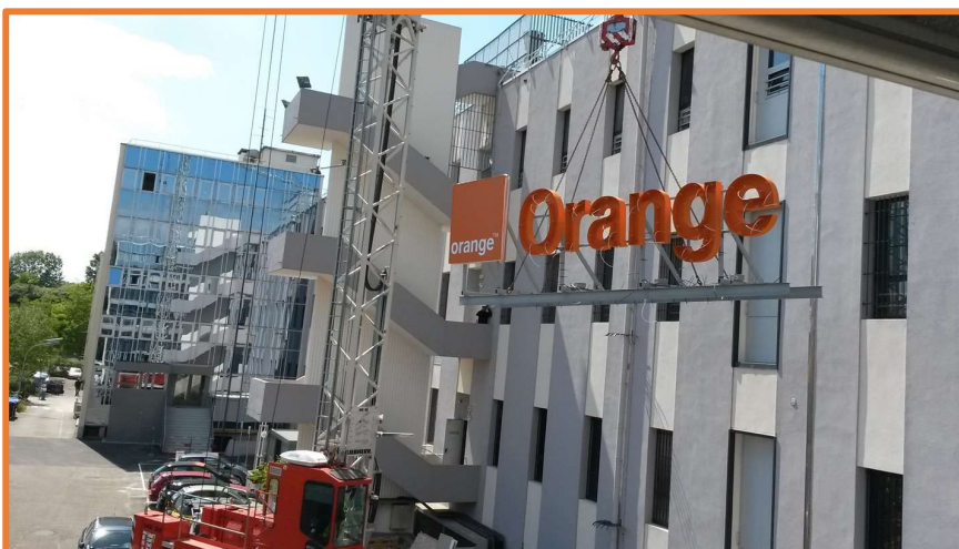
France Télécom en marche vers Orange.... L'enseigne Orange sera hissé sur le toit de Wodli quelques années plus tard
